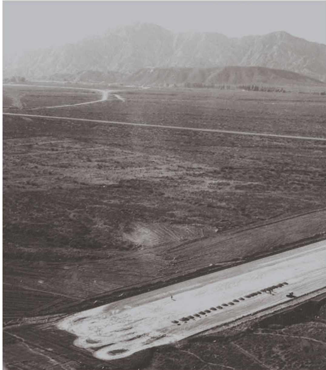
Fig. 56. Mendoza Aeroparque, aerial view of the south edge during construction phase, 1964. Aeroparque Mendoza, vista aérea del borde sur durante el periodo de construcción, 1964.
