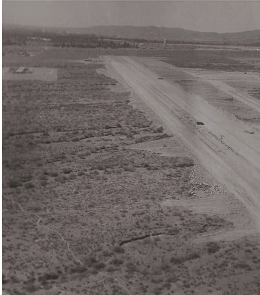
Fig. 58. Mendoza Aeroparque, aerial view of the north edge during construction phase, 1964. Aeroparque Mendoza, vista aérea del borde norte durante el periodo de construcción, 1964.
